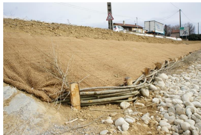
Pendant travaux janvier 2013 (©David Lardan)
