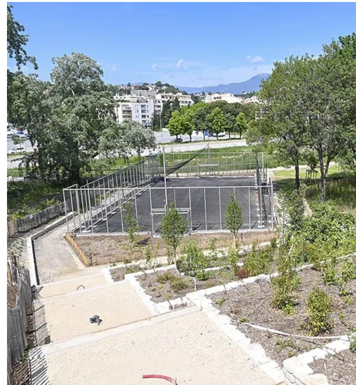
Photographies des travaux en cours :
