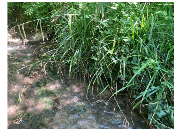
Cours d'eau renaturalisé, enrochement caché par la végétation qui habille aujourd'hui les pieds de berges
